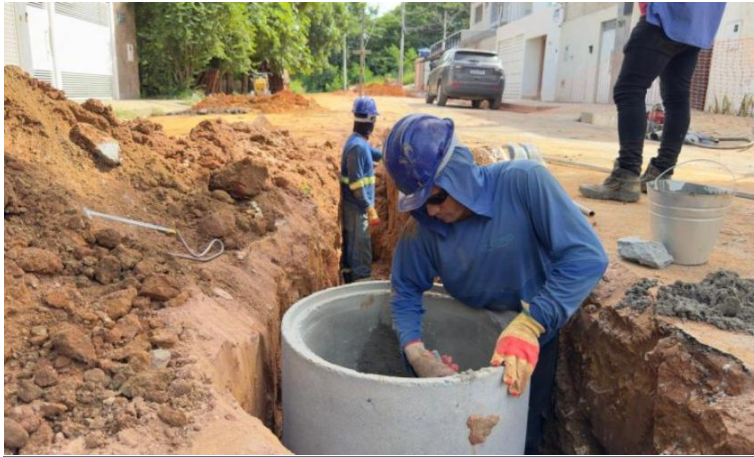
Figura 20 – Mais esgoto tratado: Águas de Valadares interliga novas redes de esgoto à ETE Santos Dumont
