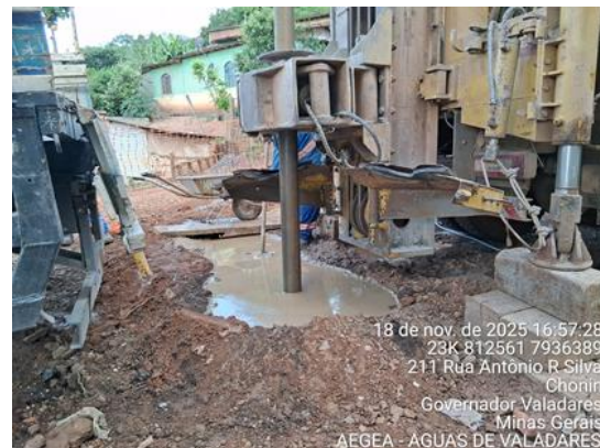
Figura 16 – Perfuração do Poço
