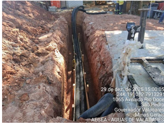
Figura 81 – Assentamento de eletrodutos
