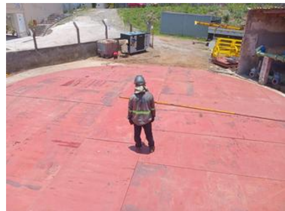
Figura 8 – Montagem do fundo do reservatório.
