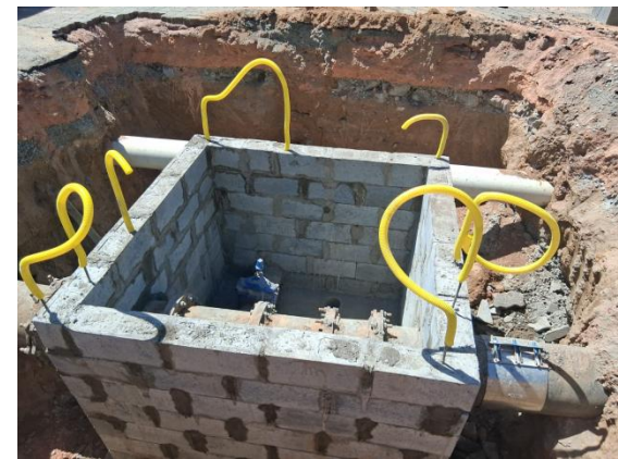
Figura 45 – Levantamento da alvenaria
