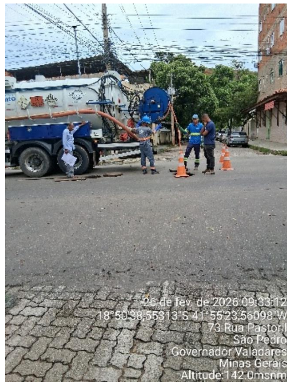
Figura 85 – Sondagem de rede através do PV.
