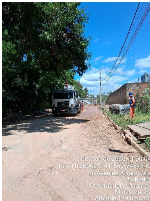
Figura 103 – Controle de material pulverulento.
