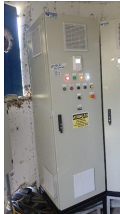
Figura 145 – Instalação de novo Quadro de Comando
