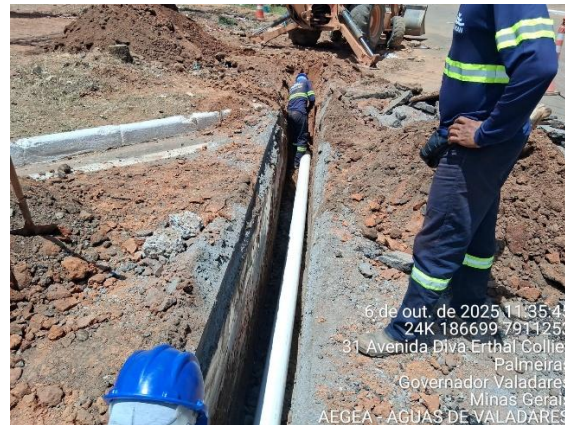
Figura 39 - Assentamento da tubulação
