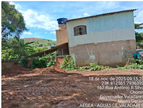
Figura 13 – Limpeza da área
