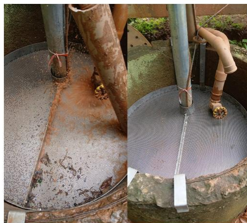
Figura 104 – Instalação de peneira no tanque para retenção
