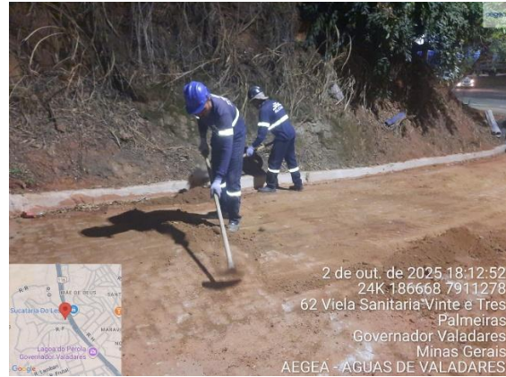
Figura 37 - Limpeza da obra
