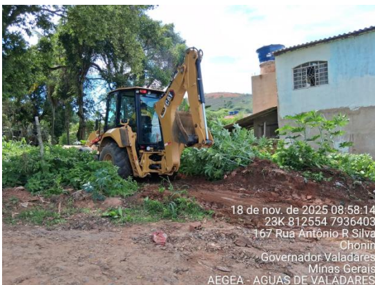
Figura 11 – Limpeza da área
