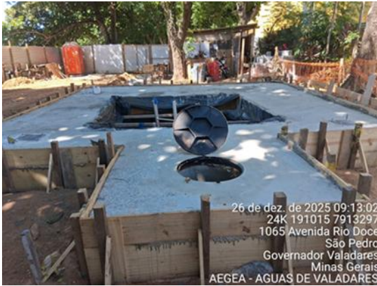
Figura 80 – Laje concretada
