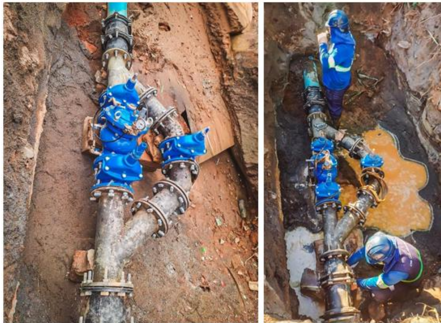
Figura 152 – Instalação de VRP 150mm na Vila Parque Ibituruna
