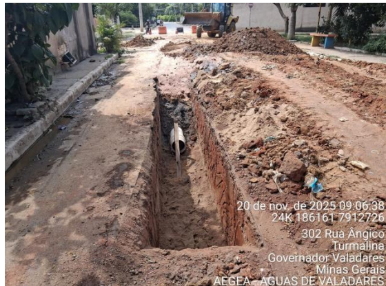
Figura 53 – Assentamento de tubos
