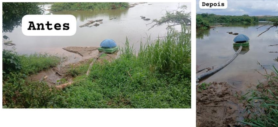
Figura 137 – Instalação de novo mangote
