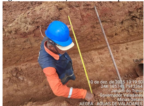
Figura 57 – Conferência da largura da escavação.
