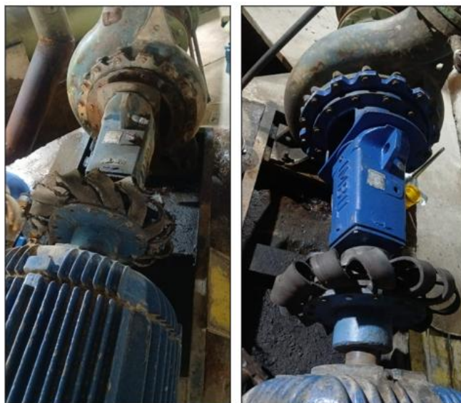
Figura 119 – Reforma de bomba centrífuga e substituição das borrachas do acoplamento
