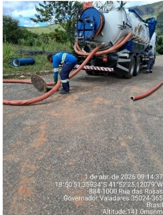
Figura 83 – Limpeza de caixa.
