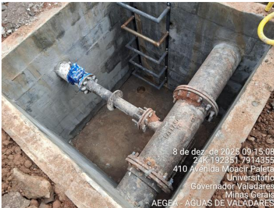
Figura 46 – Assentamento de escada metálica.
