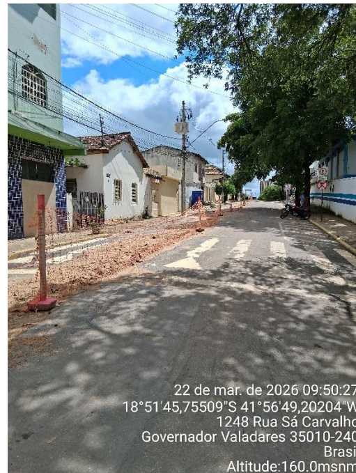
Figura 93 – Reaterro vala da adutora.
