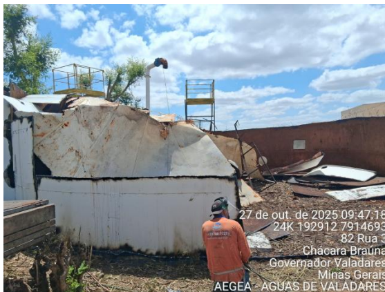
Figura 1 – Desmontagem de reservatório
