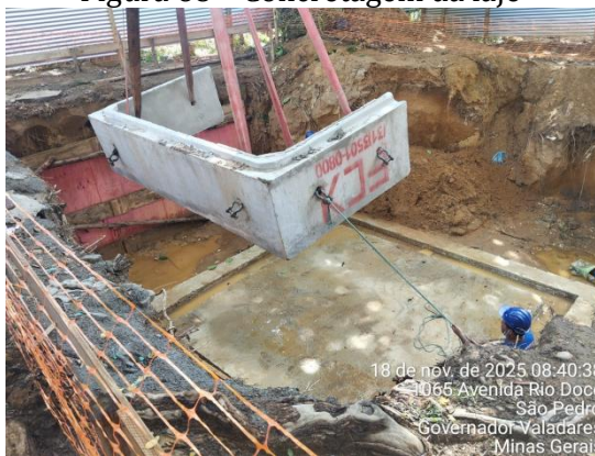
Figura 70 – Montagem das aduelas
