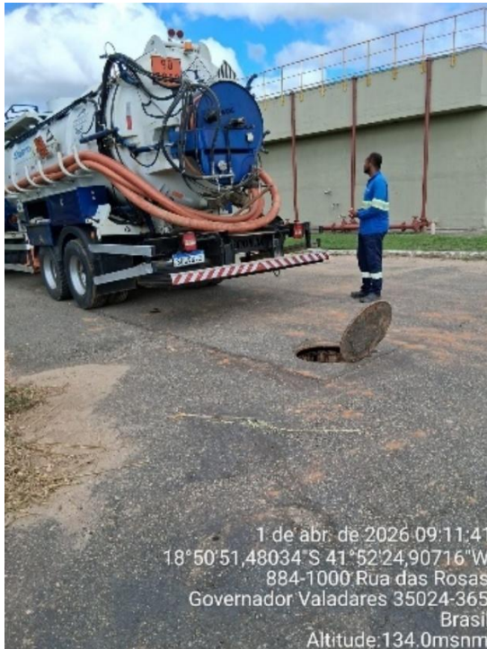
Figura 82 – Limpeza de caixa.
