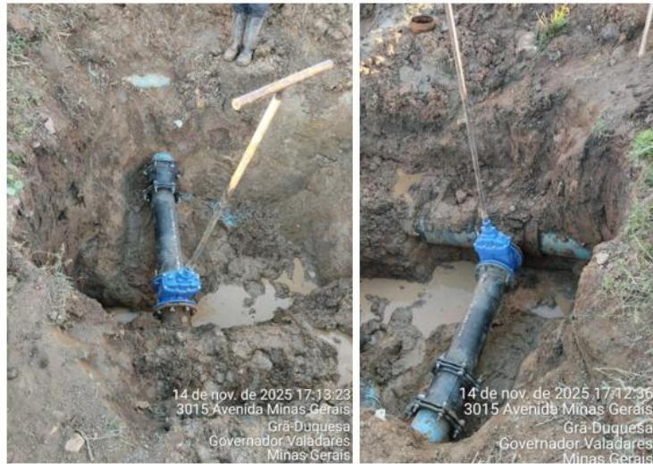
Figura 107 – Troca de registro 200mm no reservatório Morada do Vale
