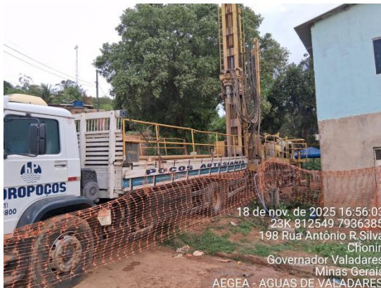
Figura 17 – Equipamentos e perfuratriz
