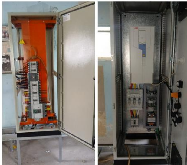
Figura 110 - Reforma da elétrica predial da EAT Altinópolis
