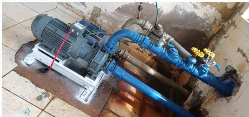
Figura 140 – Instalação de motobomba reserva
