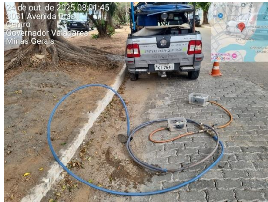
Figura 35 - Monitoramento e acompanhamento da pressão com manômetro digital.
