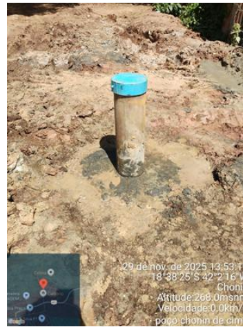
Figura 20 – Tamponamento do poço.
