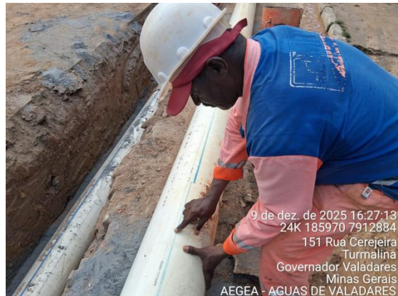
Figura 55 – Verificação da classe de pressão.
