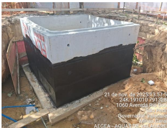
Figura 72 – Impermeabilização das aduelas
