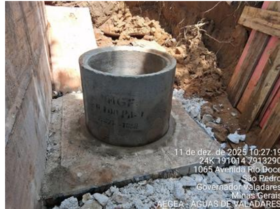
Figura 75 – Montagem do PV
