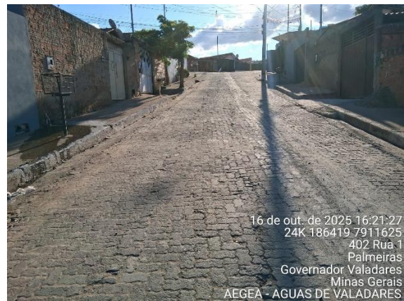
Figura 41 - Conclusão da recomposição de pavimento intertravado
