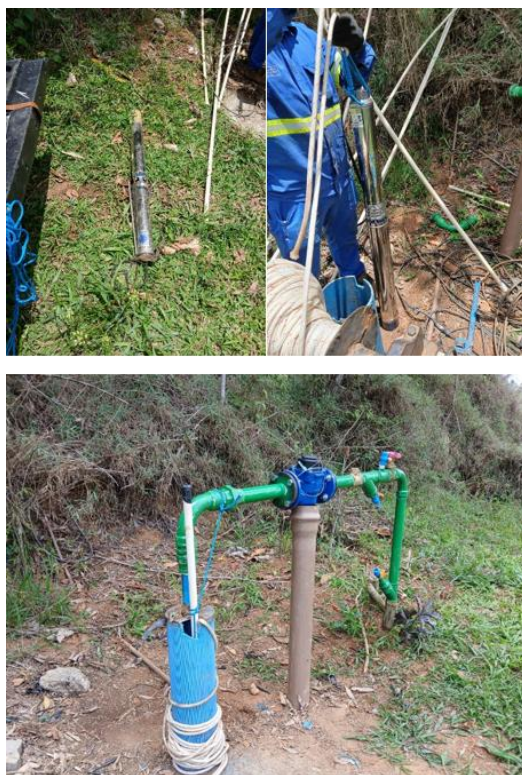
Figura 139 – Substituição da motobomba submersível
