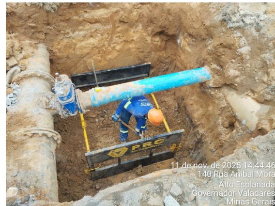
Figura 43 – Escavação e nivelamento.
