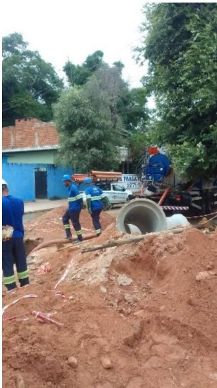
Figura 84 – Limpeza de rede de esgoto.
