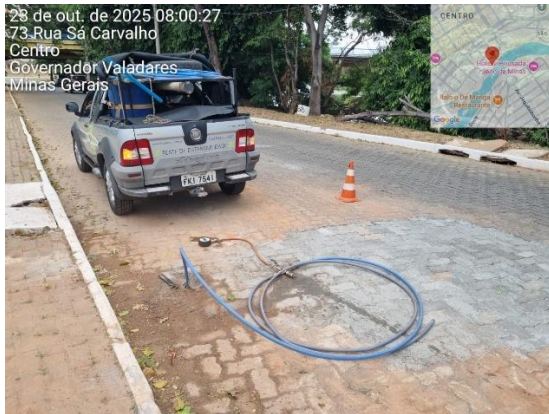
Figura 34 - Monitoramento e acompanhamento da pressão com manômetro digital.
