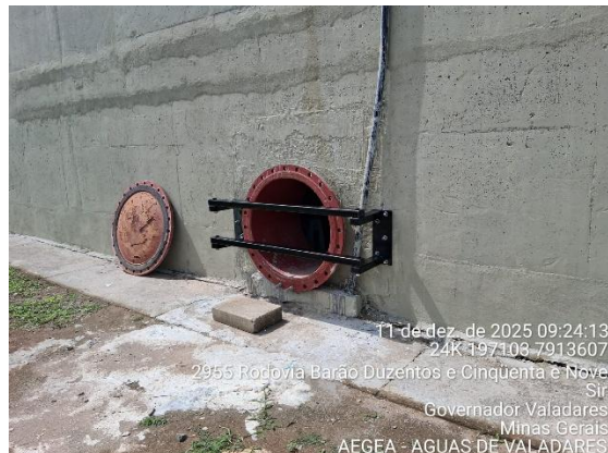
Figura 127 - Fornecimento e Instalação de suporte de apoio.
