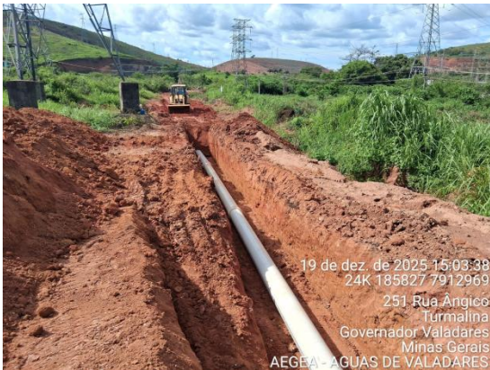
Figura 60 – Assentamento de tubos.
