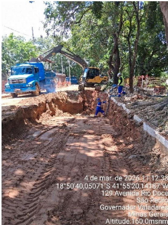
Figura 86 – Assentamento de tubulação.
