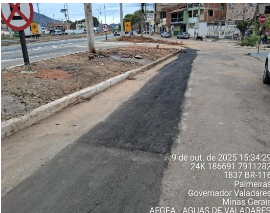
Figura 40 - Recomposição de pavimento asfáltico
