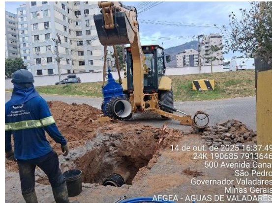
Figura 11 - Instalação de registro de gaveta e colar de tomada
