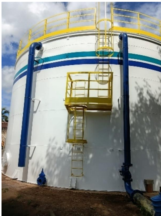
Figura 96 – Instalação da tubulação do extravasor Reservatório Braúnas.
