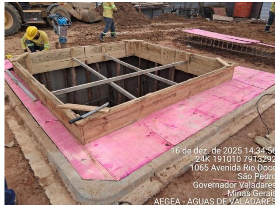
Figura 77 – Formas para a concretagem da laje superior
