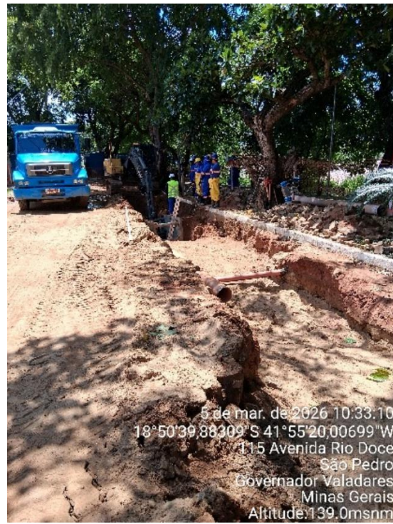
Figura 87 – Assentamento de tubulação.
