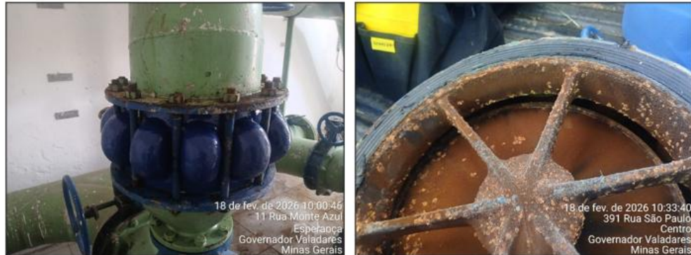
Figura 118 – Substituição de válvula de retenção
