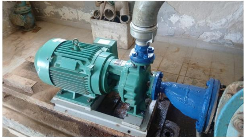
Figura 138 – Instalação de motobomba
