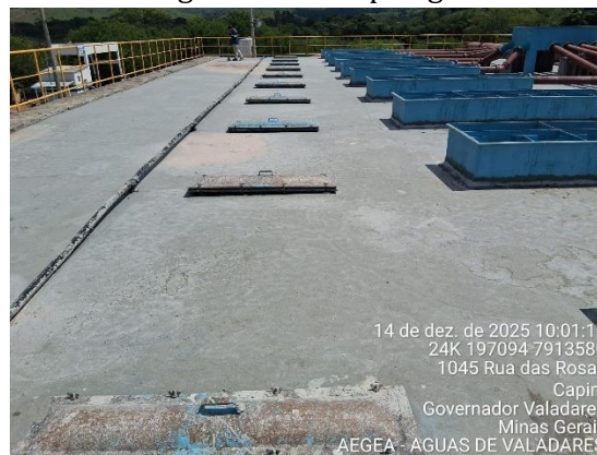
Figura 125 - Instalação de borrachas de vedação nas tampas
