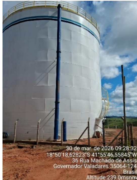
Figura 95 – Instalação da tubulação do extravasor Res. Belvedere.
