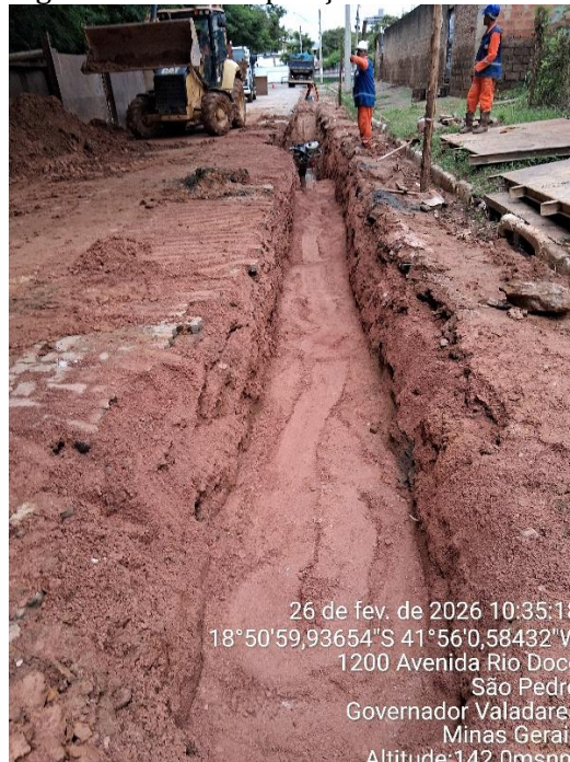
Figura 101 - Recomposição e compactação de vala.
