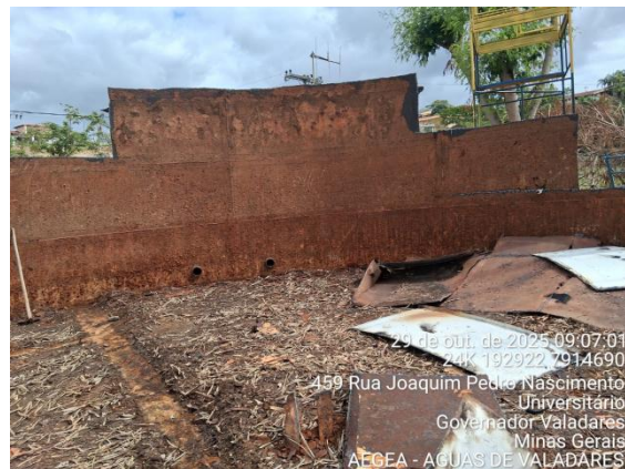
Figura 2 – Desmontagem de reservatório
