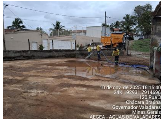
Figura 6 – Limpeza da base.
