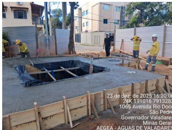
Figura 79 – Conclusão da concretagem da laje superior
