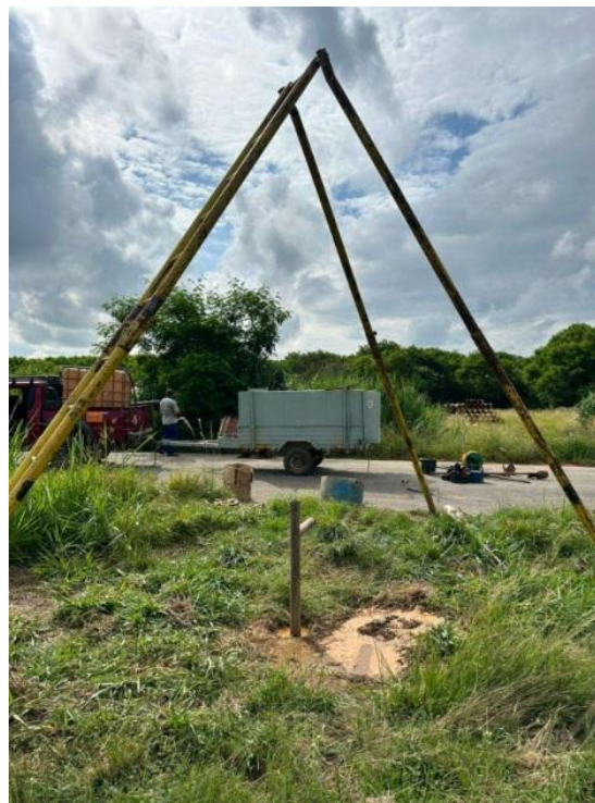
Figura 129 – Execução ensaio ETE Santos Dumont.
