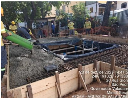
Figura 78 – Concretagem da laje superior
