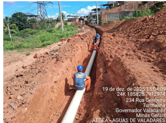
Figura 61 – Assentamento de tubos.
