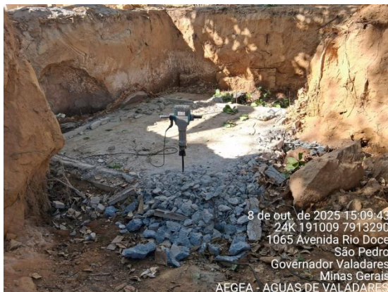
Figura 64 – Demolição de laje de fundo
