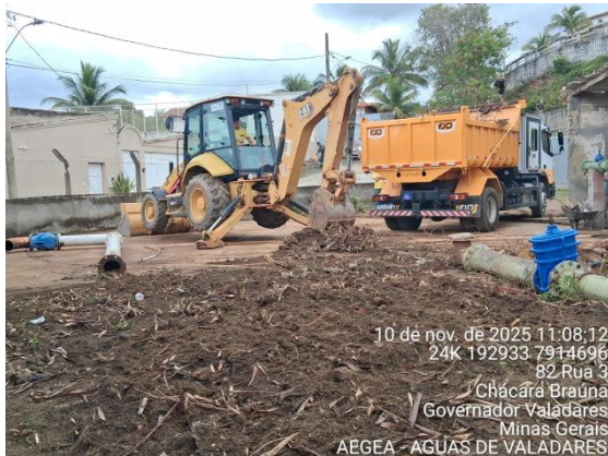
Figura 5 – Limpeza da área.
