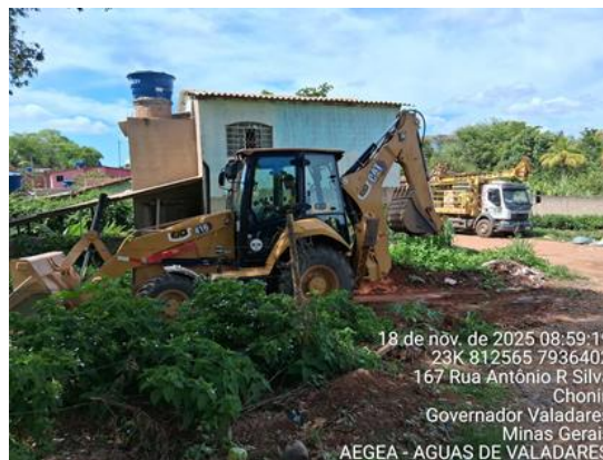
Figura 12 – Limpeza da área
