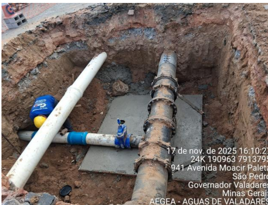
Figura 44 – Concretagem de fundo
