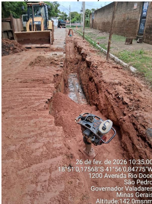
Figura 100 - Recomposição e compactação de vala.
