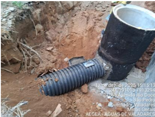
Figura 76 – Instalação de tubo ADS DN 600mm
