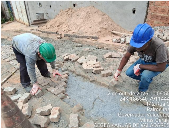
Figura 36 - Recomposição de pavimento intertravado
