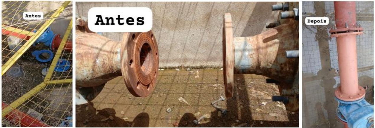
Figura 153 – Instalação de VRP DN150 adaptada para função VRN
