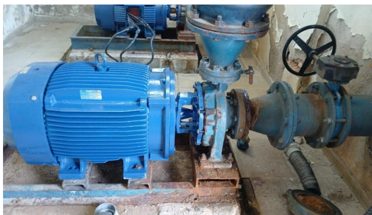
Figura 106 – Reforma de motobomba da EAT Carapina
