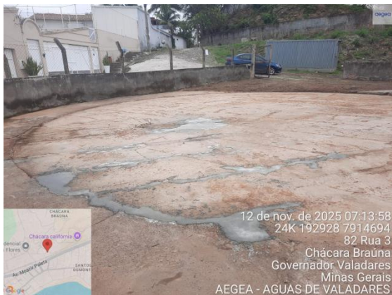
Figura 7 – Tratamento da base do reservatório.
