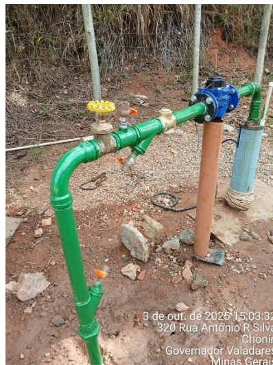
Figura 136 – Instalação de barrilete padrão
