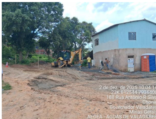
Figura 21 – Limpeza final de obra.
