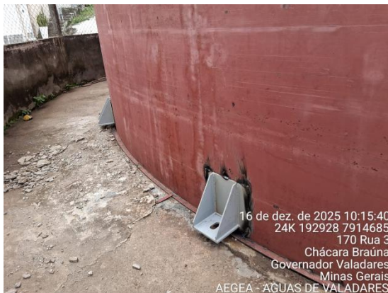
Figura 9 – Instalação do suporte de ancoragem.
