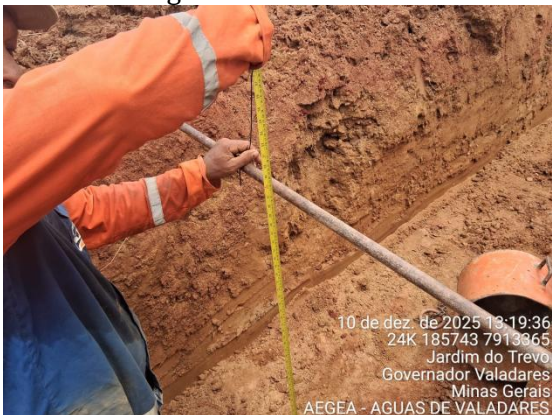
Figura 56 – Conferência da profundidade da escavação.
