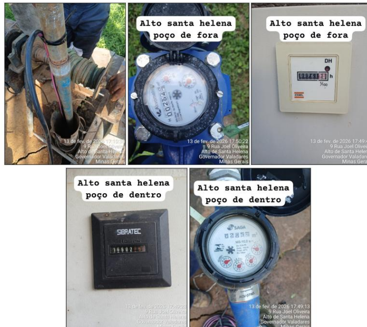
Figura 114 – Limpeza do poço de Alto de Santa Helena
