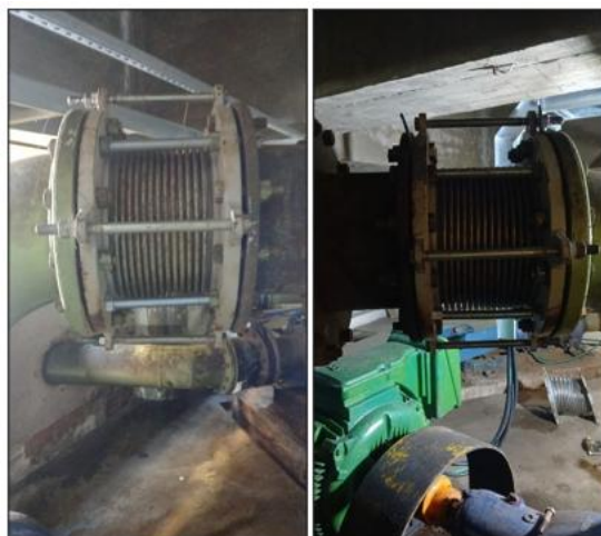
Figura 120 – Substituição de junta de expansão DN 250
