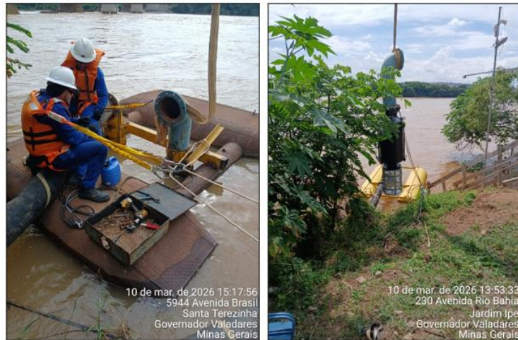
Figura 141 – Instalação de motobomba anfíbia
