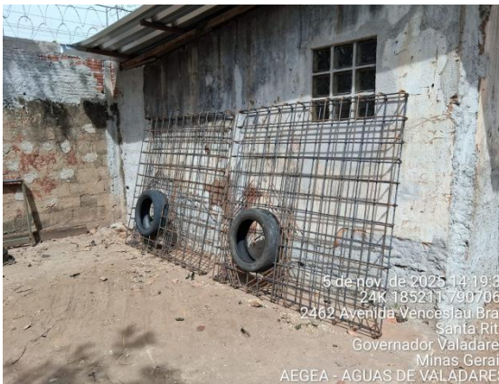
Figura 42 – Armação para tampa de concreto.
