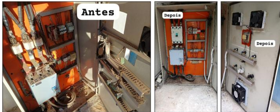
Figura 115 – Retrofit no QCM do EAT Altinópolis Horizontal
