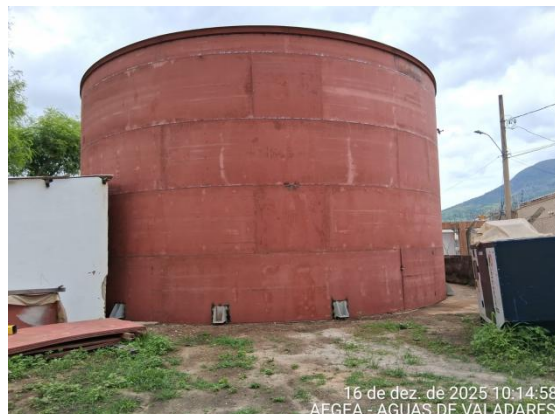
Figura 10 – Montagem do costado.
