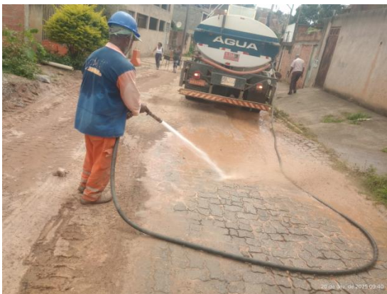
Figura 62 – Limpeza de vias.
