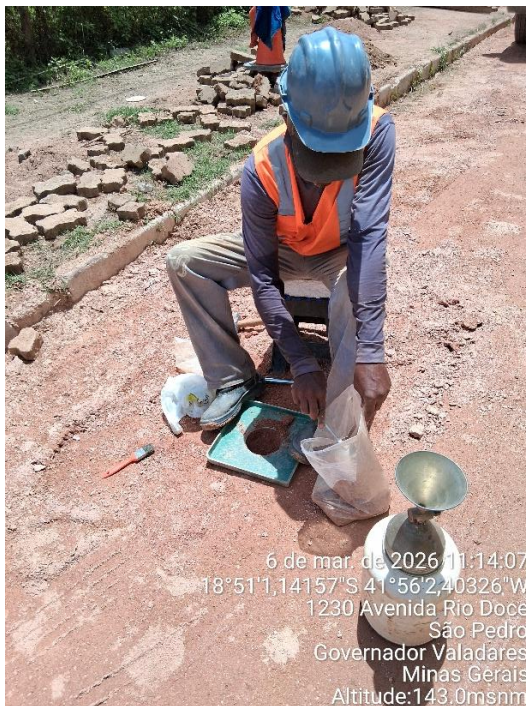
Figura 102 – Ensaio de compactação de solo.
