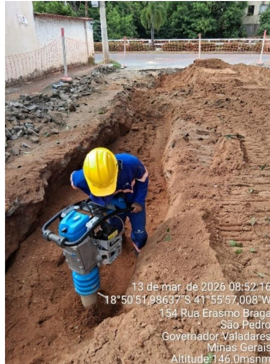
Figura 91 - Reaterro e compactação da vala.
