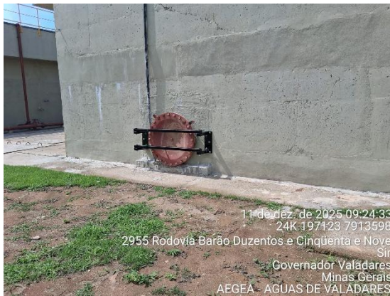
Figura 126 – Fornecimento e Instalação de suporte de apoio.
