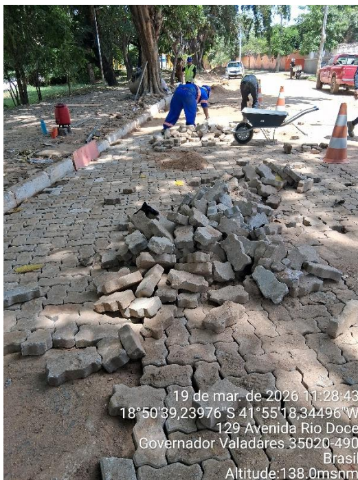
Figura 88 – Reconstituição calçamento.
