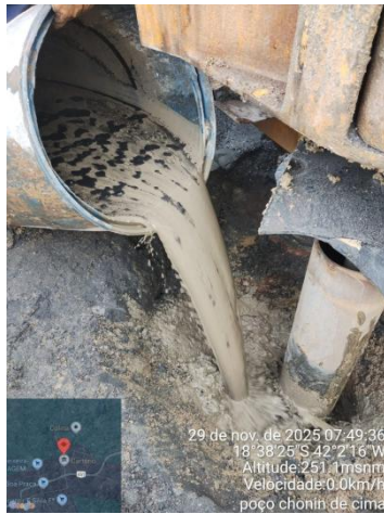
Figura 19 – Injeção de calda de cimento.
