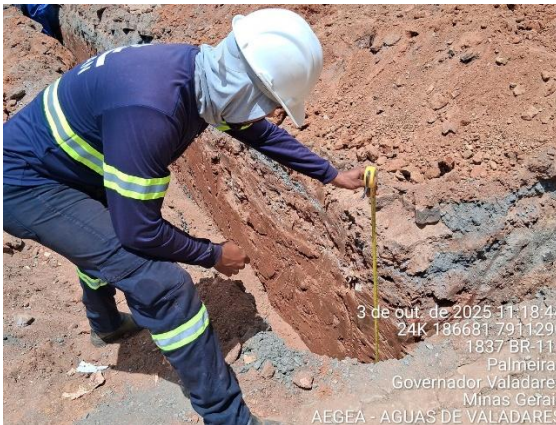
Figura 38 - Conferência da profundidade da vala
