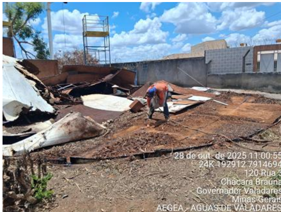
Figura 3 – Desmontagem de reservatório
