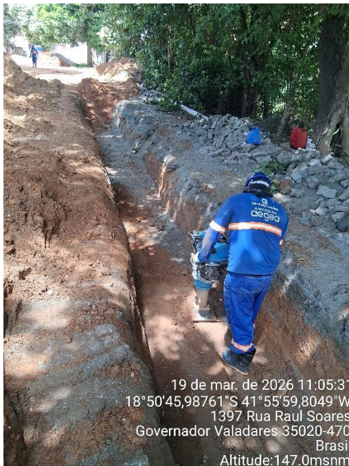
Figura 92 – Compactação de vala.
