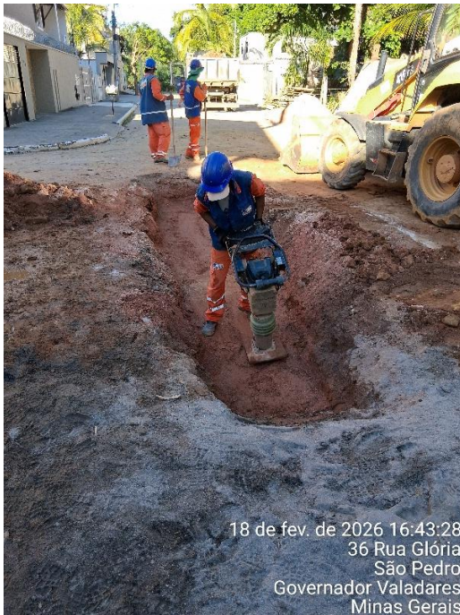
Figura 98 – Compactação de solo.
