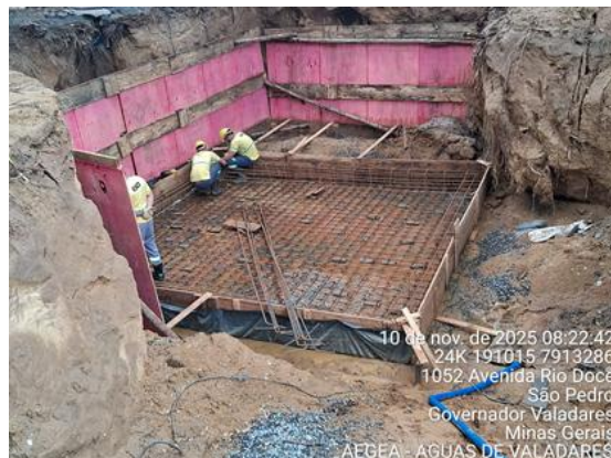
Figura 65 – Armação da laje de fundo
