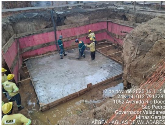
Figura 68 – Concretagem da laje
