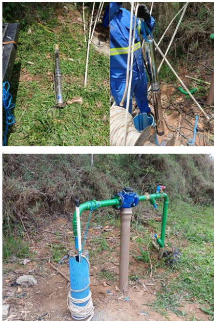
Figura 139 – Substituição da motobomba submersível
