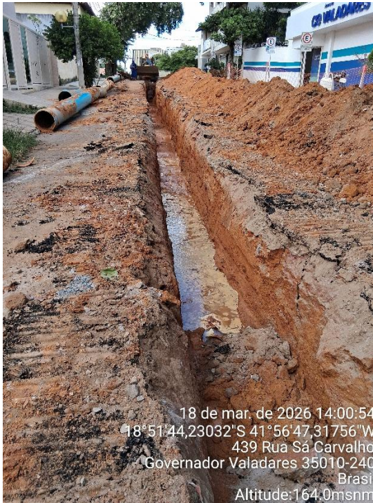
Figura 90 – Assentamento de tubos adutora Belvedere.
