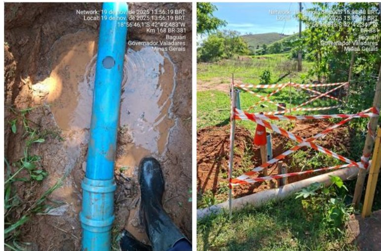
Figura 111 - Instalação de ventosa na rede de DN110 em Baguari
