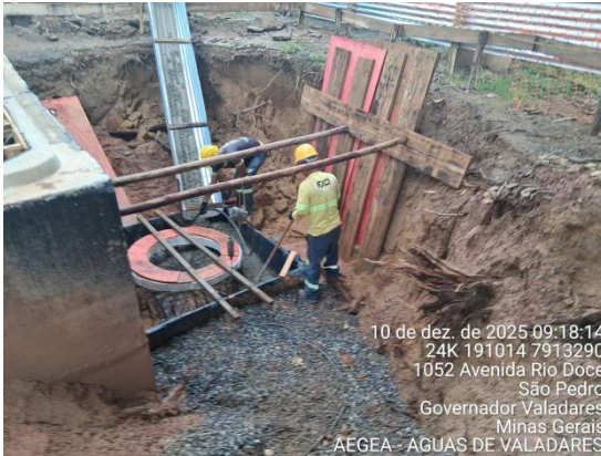
Figura 74 – Concretagem da laje do PV
