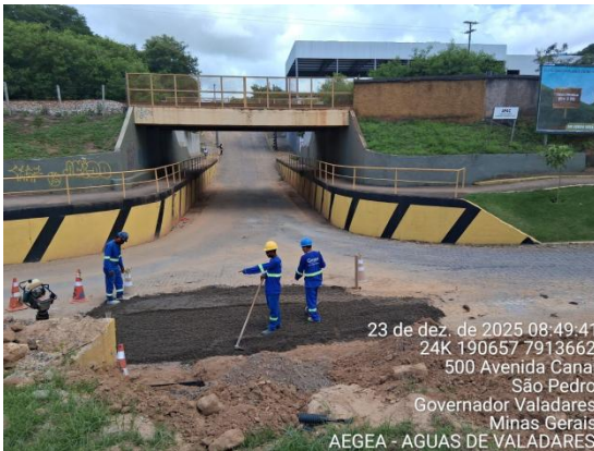
Figura 48 – Lançamento de base com BGS.
