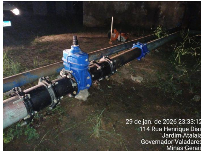
Figura 117 – Instalação de registro DN 200
