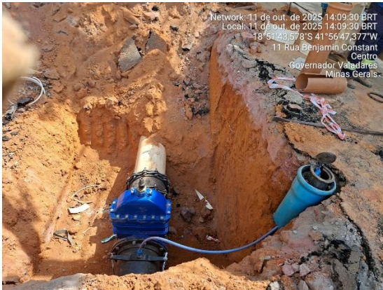
Figura 30 – Instalação de registro de gaveta e colar de tomada
