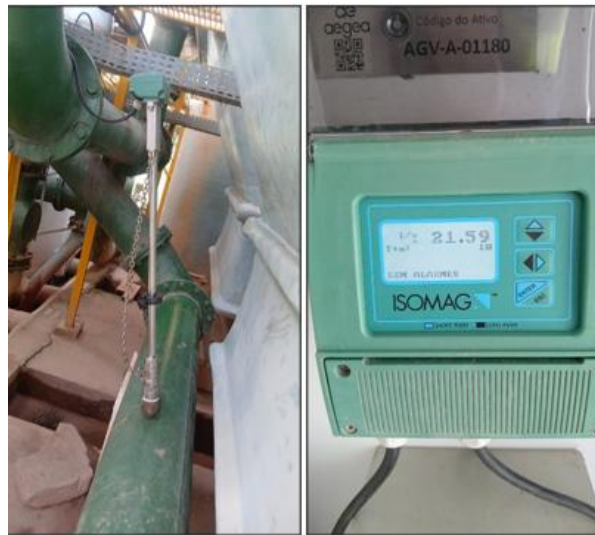
Figura 149 – Instalação de macromedidor eletromagnético por inserção
