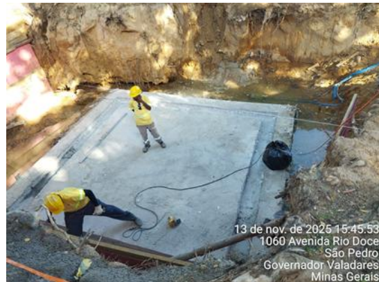
Figura 69 – Limpeza e desforma
