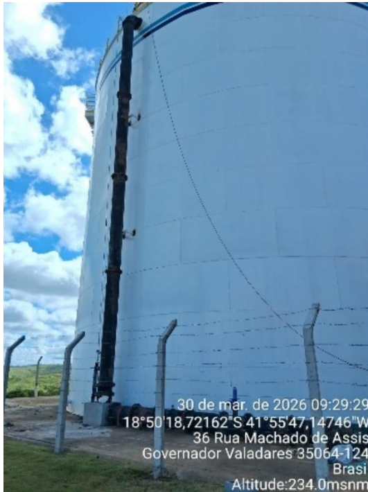
Figura 94 – Fixação tubulação da rede de abastecimento Res. Belvedere.
