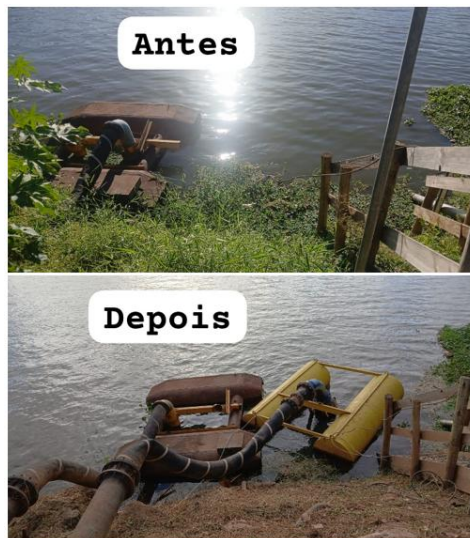
Figura 135 – Instalação de bomba anfíbia
