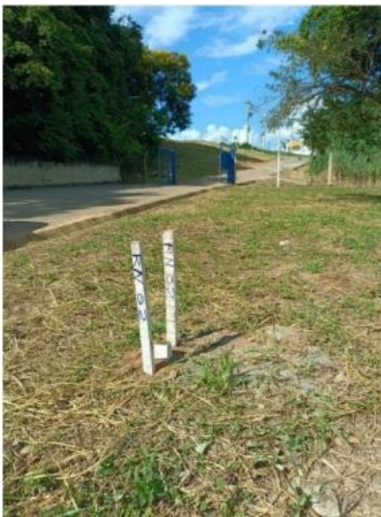
Figura 132 – Marco de concreto piramidal ETA Recanto dos Sonhos.
