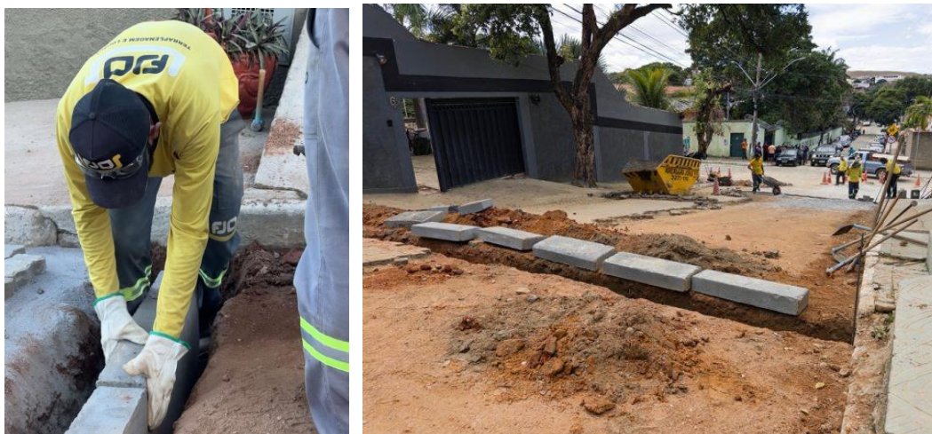
Figura 65 – Melhorias contínuas: Águas de Valadares inova com técnicas de recomposição das vias
