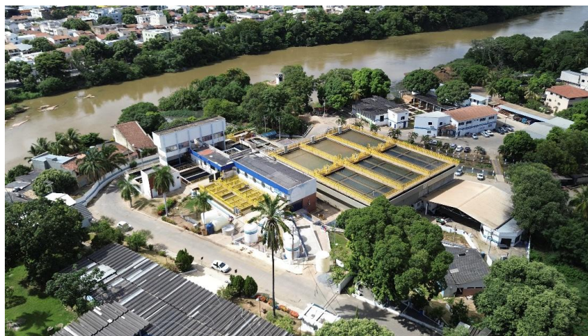
Figura 61 – Para melhorias no sistema, Águas de Valadares programou parada no abastecimento
