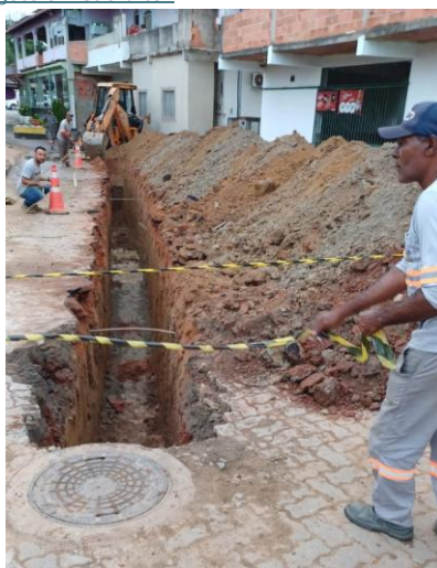
Figura 42 – Águas de Valadares substitui redes de esgoto em São Vitor
