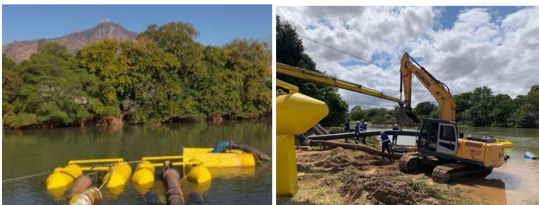
Figura 68 – Bombas anfíbias são aliadas da Águas de Valadares na estiagem
