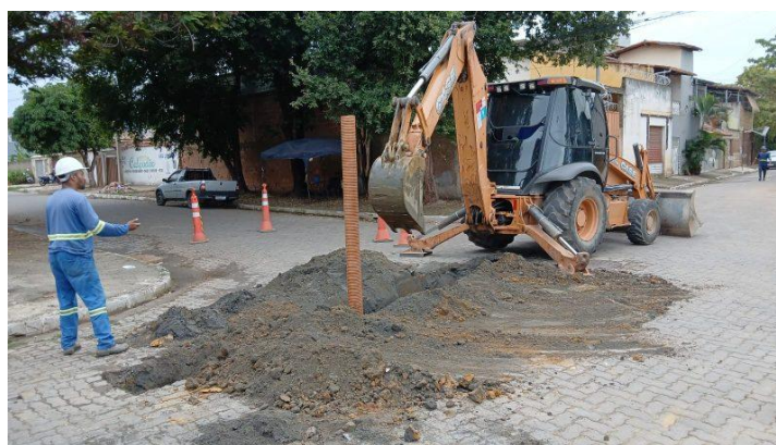
Figura 56 – Finalização da primeira etapa das obras de modernização das redes de água do Santa Rita
