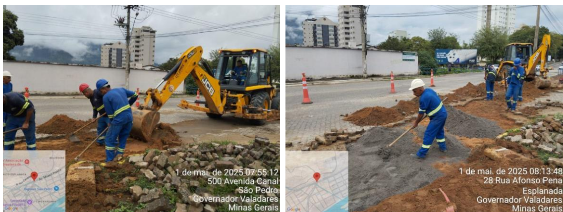
Figura 50 –Recomposição de pavimento na região da Moacir Paleta com Afonso Pena
