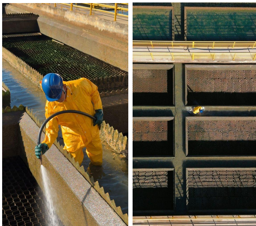
Figura 63 –Limpeza nos tanques da ETA Central nesta semana
