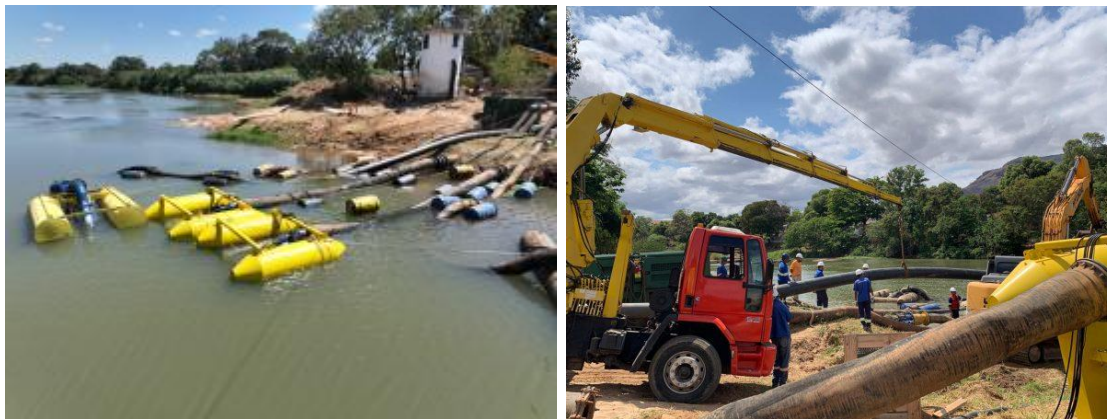
Figura 67 – Bombas anfíbias são aliadas da Águas de Valadares na estiagem
