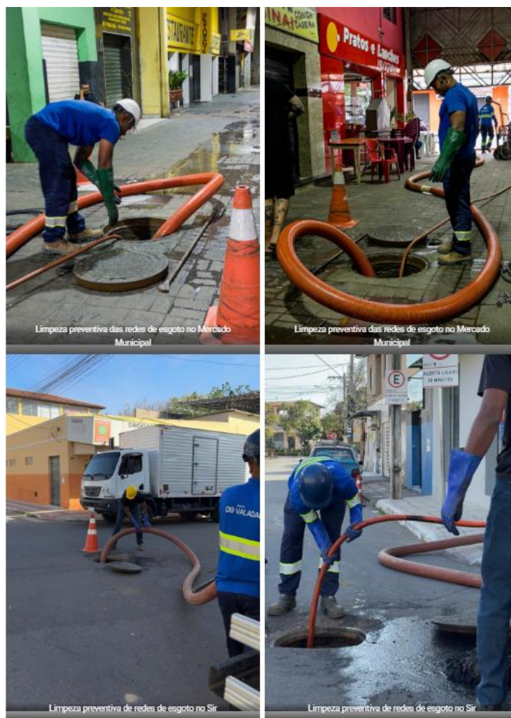
Figura 48 –Manutenções preventivas nas redes de esgoto da cidade
