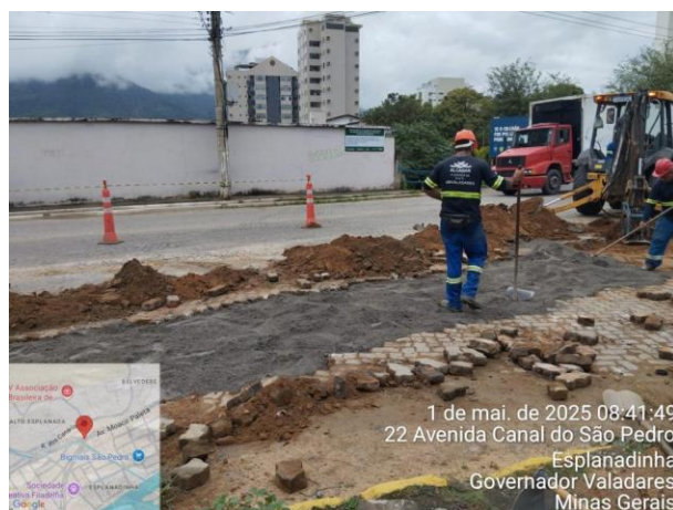
Figura 51 –Recomposição de pavimento na região da Moacir Paleta com Afonso Pena
