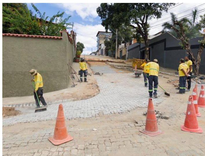
Figura 66 – Melhorias contínuas: Águas de Valadares inova com técnicas de recomposição das vias
