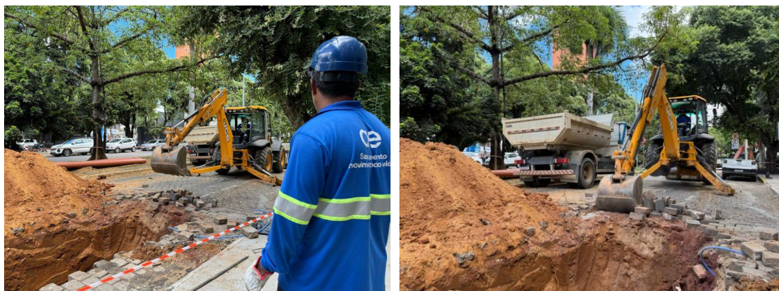
Figura 39 – Melhorias: substituição de rede em trecho da Avenida Brasil
