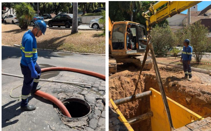
Figura 41 – Trecho da Avenida Brasil recebeu nova rede de esgoto
