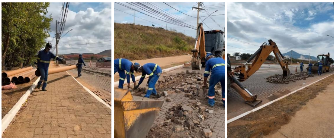
Figura 47 – Águas de Valadares ampliou rede de esgoto auxiliar no Estradão do Penha
