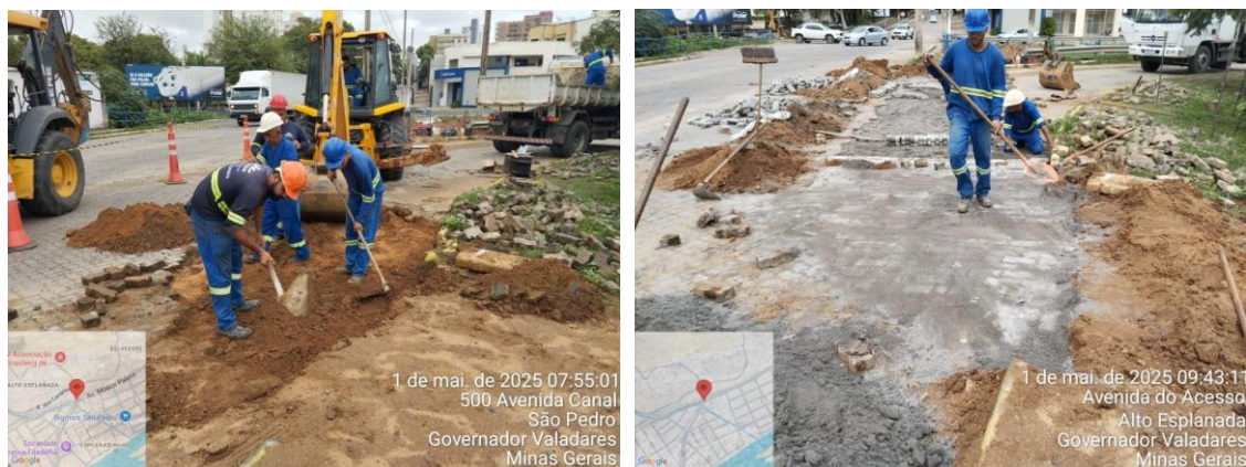
Figura 49 –Recomposição de pavimento na região da Moacir Paleta com Afonso Pena
